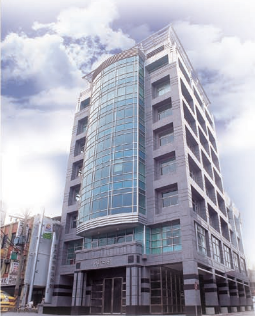
▼ 新大樓於2002年6月完工
