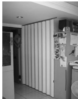
裝設軌道式PVC拉門情形
