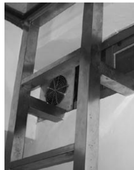
新裝地下室抽風扇及封板
