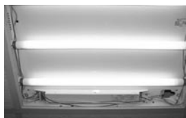
18W三波長燈管電子式安定器燈具
