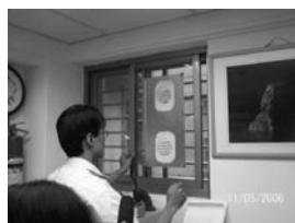
▲ 一樓辦公區安裝全熱交換空氣對流機情形
