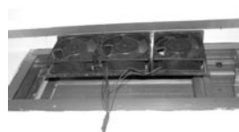
原有舊抽風扇未設封板
