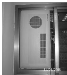
原有舊抽風扇未設封板
