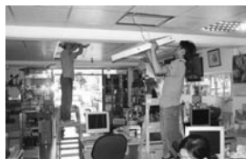
正在更換電子式安定器T-Bar燈具
