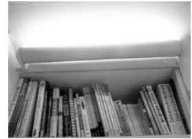
大門入口處上方和門旁書櫃兩處傳統日光燈具改為電子式安定器
