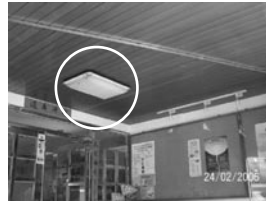
大門入口處上方和門旁書櫃兩處傳統日光燈具改為電子式安定器
