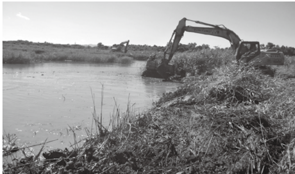
↑怪手搭配堆土機的施工方式很快速，但干擾破壞性大
