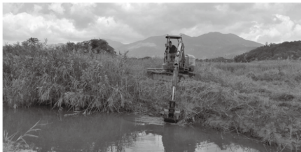
↑ 棲地復育工程進場後首先開始整理池岸邊的高莖草（葉再富攝）
