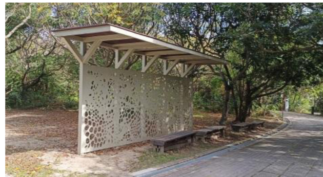
▲ 增設涼亭提供入園遊客休憩
