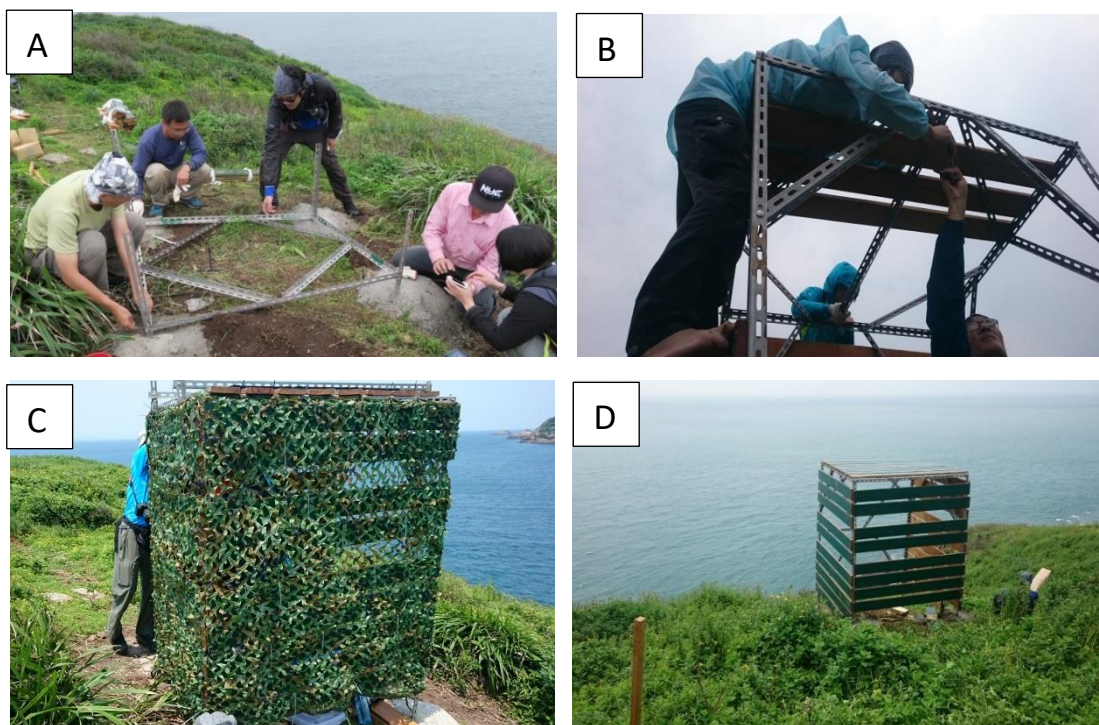
圖三、簡易觀察站之架設。A、B-施工過程。C-鐵尖。D-中島。
