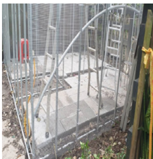
▲ 拆掉舊籠舍重建
